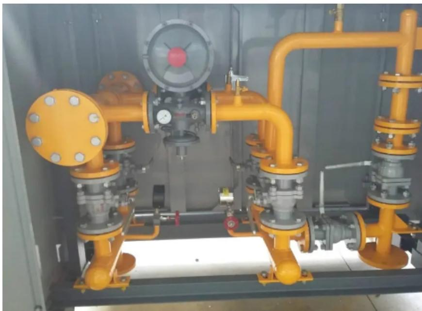
针对CNG减压撬设备，每次运用前，应查看控制台上各外表和指示灯状况，热水及压缩空气参数和设备运行状况，现场工艺流程和阀门方位。以上各项查看均正常后，敞开卸气阀门，总进口阀，按下场发动按钮，该调压设备投入正常运用。正常停机时，封闭卸气阀门，总进口阀，按下场停机按钮。根据工艺要求封闭各相关阀门，辅助设备，必要时应考虑热水体系排空和电体系断电。该调压设备处于停机备用状况□CNG减压撬设备呈现反常情况时，将自动封闭紧迫堵截阀并用声光信号在中控室报警。反常情况人为干涉或自动消除后，可按正常发动过程重新发动。任何时候，只需各级压力超高、换热回水温度过低一级恣意一种反常情况存在，该调压设备均被强制为停机状况，直至反常原因被找到并扫除后，才可能被重新运用。调压箱的设计、加工、检测等工序要符合要求。桥东区区域调压箱报价
